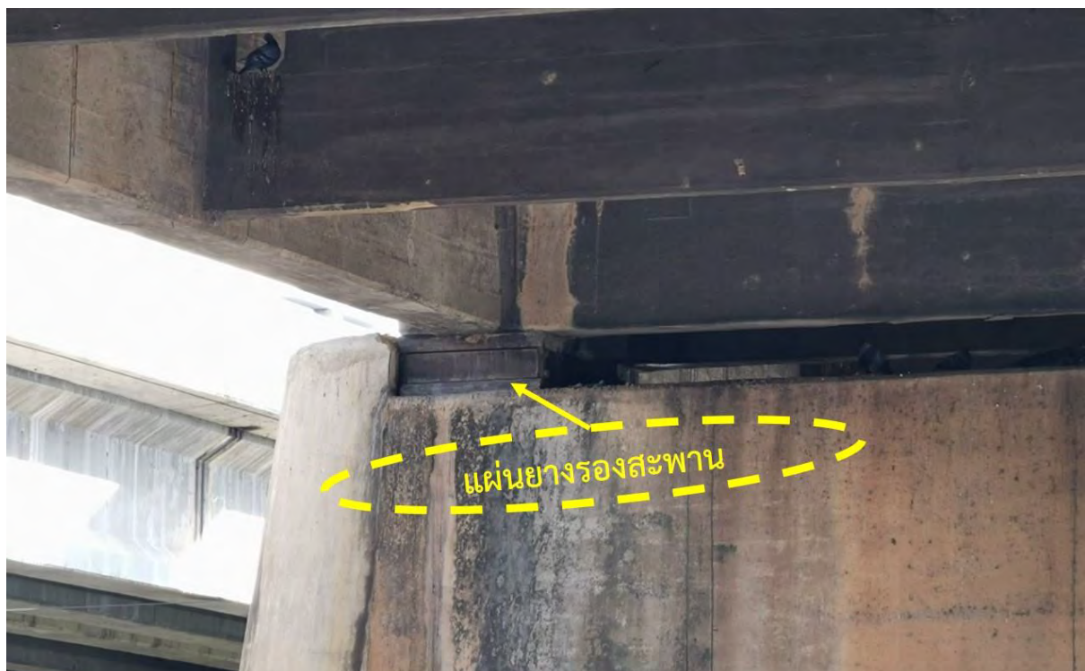
รูปที่ 10.2-6 แผ่นรองคานสะพาน
