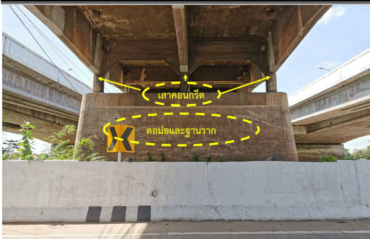
รูปที่ 10.2-5 เสาคอนกรีตและตอม่อสะพาน
